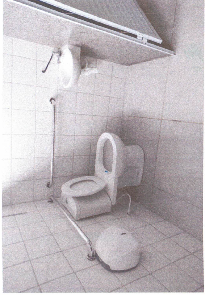
VISTA GERAL BANHEIRO PNE - FEMININO
