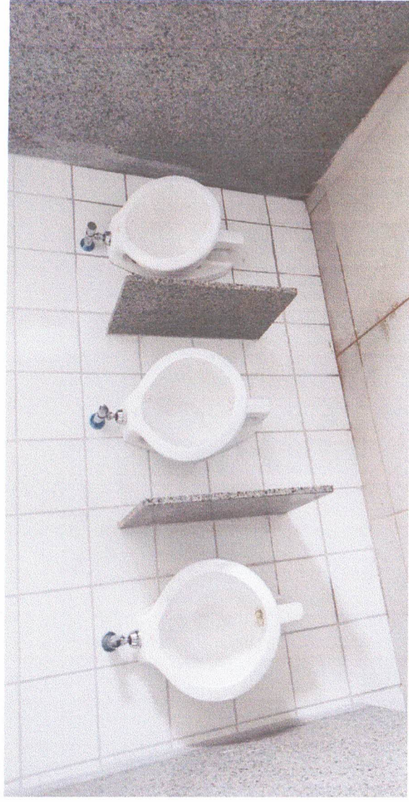
MICTÓRIOS COM VÁLVULAS AUTOMÁTICAS
