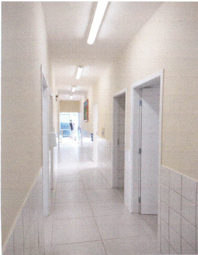
VISTA GERAL ILUMINAÇÃO
